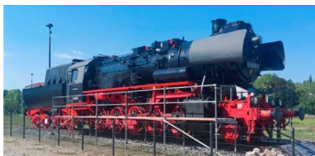
Auf beiden Seiten der Lok stehen Gerüste, um die Arbeiten zu erleichtern. (Foto: Frank Möckel)
