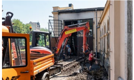
Die Schachtarbeiten haben wir bereits in Eigenleistung erbracht. (Foto: Bernd Hahn)
