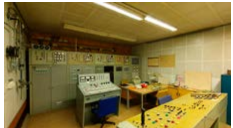
Der Bunker Garzau beherbergte das Organisations- und Rechenzentrum (ORZ) der Nationalen Volksarmee der DDR. (Foto: Outdoor Sports GmbH)
