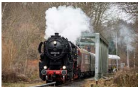
Die Neißebrücke bei Hirschfelde ist heute ein Eisenbahn-Grenzübergang. (Foto: Bernd Hahn)
