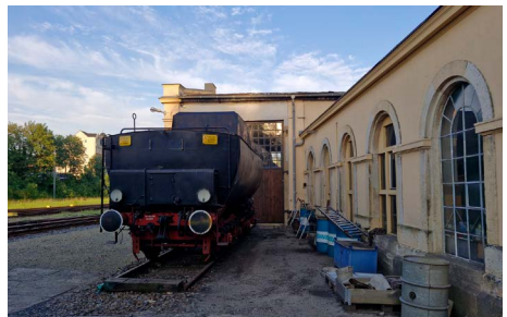
Stand 1 beherbergt aktuell die abgestellte Dampflokomotive 52 8080-5. Der Tender muss jedoch draußen stehen. (Foto: Maximilian Schöne)
