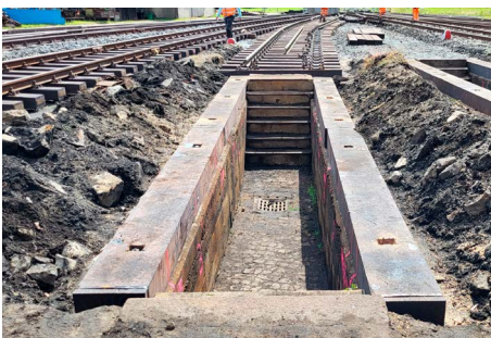
Die neuen Schwellen an den Untersuchungsgruben sorgen für den sicheren Halt der Schienen. (Foto: Maximilian Schöne)
