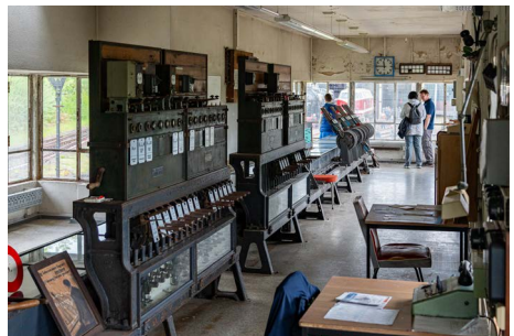
Das Stellwerk W5/6 mit seiner original erhaltenen mechanischen Ausrüstung. (Foto: Bernd Hahn)
