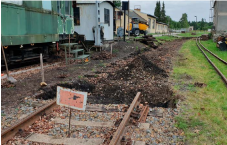
Auch hier begannen die Arbeiten mit dem Ausbau des alten Gleises. (Foto: Maximilian Schöne)
