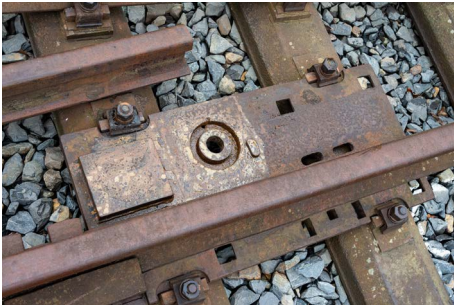
Im hier sichtbaren runden Lager sitzt später das fixierte Ende der Weichenzunge. (Foto: Bernd Hahn)
