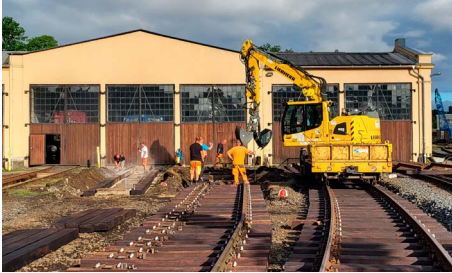
Während der Arbeiten kam schwere Technik zum Einsatz. (Foto: Maximilian Schöne)
