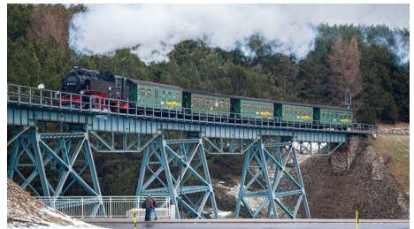
Kurz vor dem Bahnhof Oberwiesenthal passiert die Fichtelbergbahn das Hüttenbachviadukt. (Foto: Bernd Hahn)
