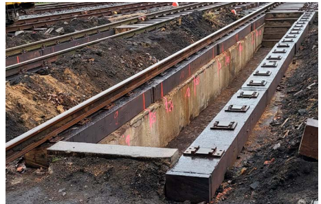
Während links die Schiene bereits eingebracht ist, sind auf der rechten Seite die Rippenplatten auf der Schwelle gut zu erkennen. (Foto: Maximilian Schöne)
