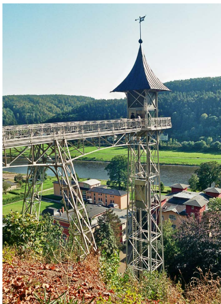
Der 1905 errichtete Personenaufzug verbindet Bad Schandau mit dem Fußweg zum Ortsteil Ostrau. (Foto: Ralph Gruner)
