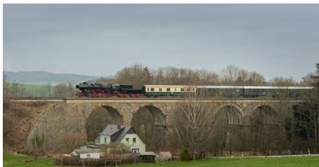
52 8141-5 auf dem Höllengrundviadukt bei Großschweidnitz. (Foto: Bernd Hahn)
