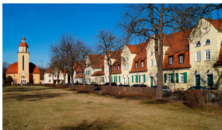
Anger und evangelische Pfarrkirche der Gartenstadt Lautau-Nord. (Foto: Ralph Gruner)
