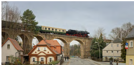
OSEF-Sonderzug auf dem Ebersbacher Viadukt. (Foto: Bernd Hahn)
