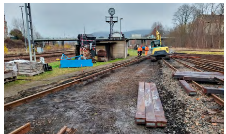
Weiche 61 ist fast komplett ausgebaut und bereit zur Einbringung des neuen Schotterbettes.
