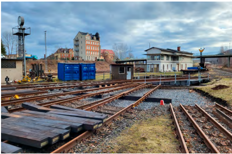
Das neue Schotterbett an der Schwenkscheibe ist gelegt. (Foto: Maximilian Schöne)
