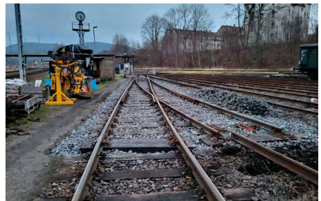
Weiche 61 ist komplett wiederhergestellt.
