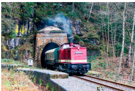
OSEF-Sonderzug in einem der 7 Eisenbahntunnel im Sebnitztal. (Foto: Stephan Klotzsch)
