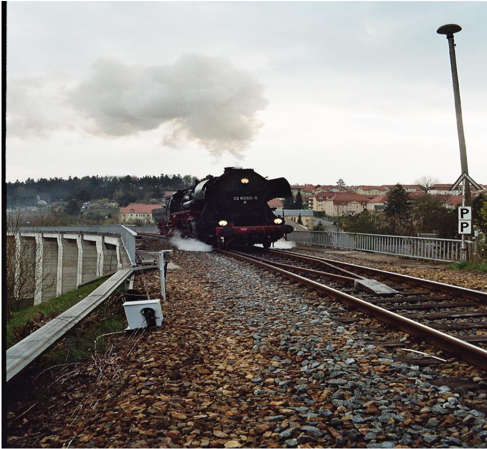
Dampflok 52 8080-5 auf dem Sebnitzer Stadtviadukt (Foto: Ralph Gruner)
